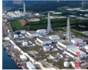
東京電力ホールディングス株式会社 柏崎刈羽原子力発電所
