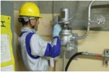
現場計器の点検
