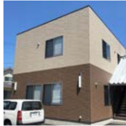
檜葉事務所・檜葉倉庫
