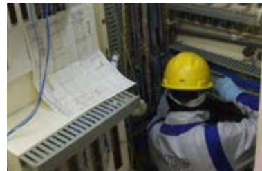
計装制御盤の交換
